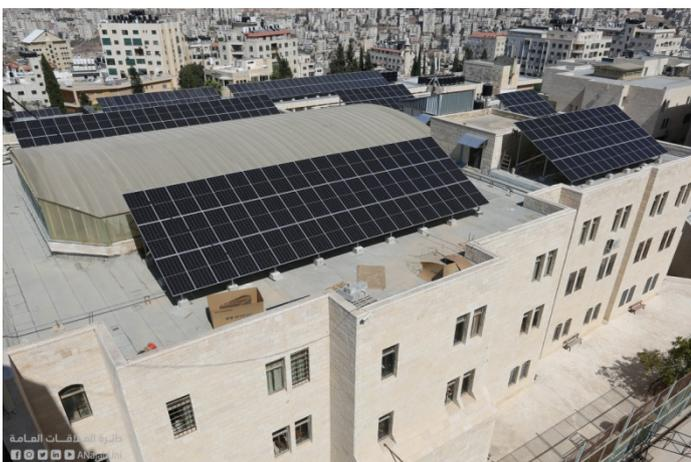
Nell'ambito del progetto Med-EcoSuRe, sono stati installati impianti solari fotovoltaici sul tetto di diversi edifici presso l'Università Nazionale An-Najah, in Palestina, con una capacità totale di 165 kW.
